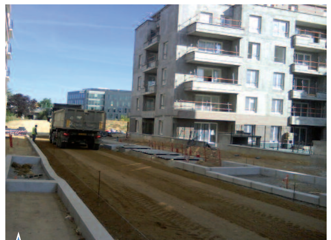
STRUCTURE DE LA VOIRIE RÉALISÉE EN URBASOL
