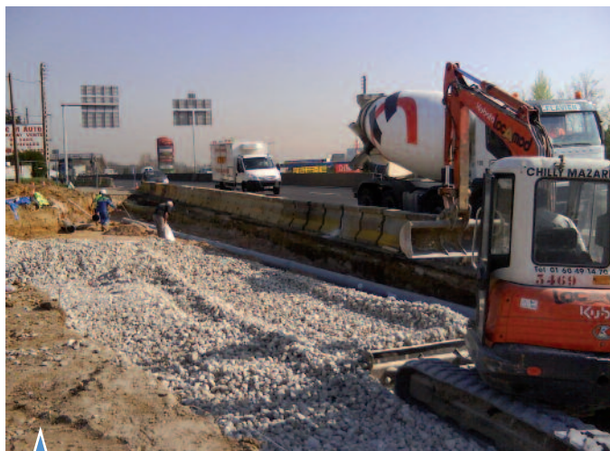
MISE EN ŒUVRE DU CAILLOU DE BÉTON
