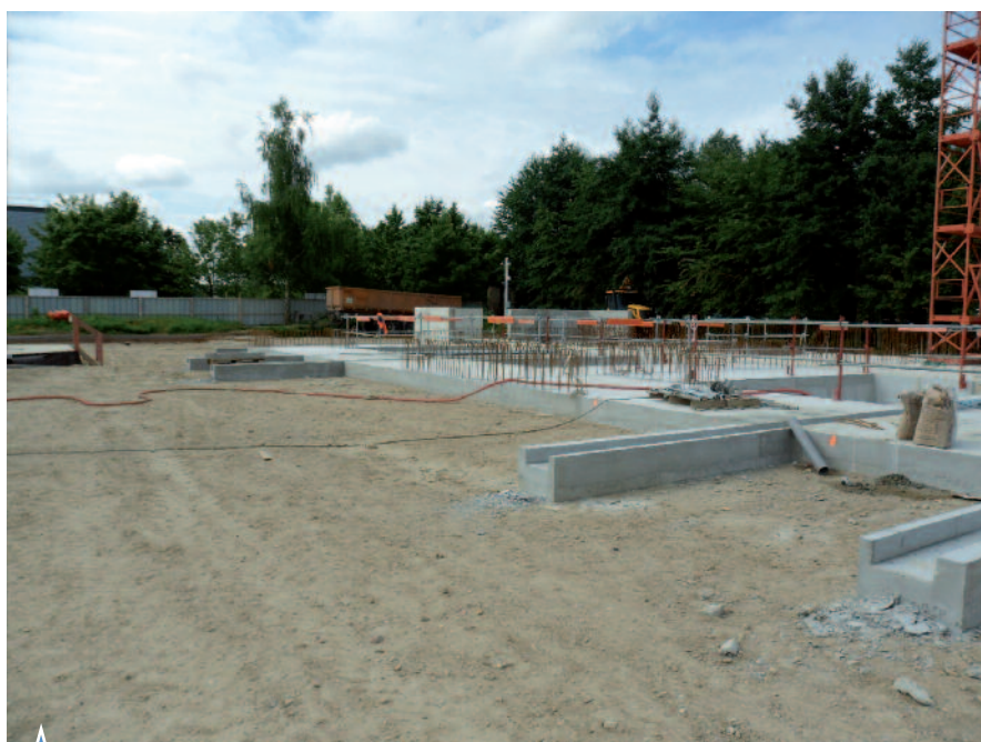
REMBLAI EN URBASOL RÉALISÉ AUTOUR DES BÂTIMENTS DU POSTE SOURCE DU GENITROY
